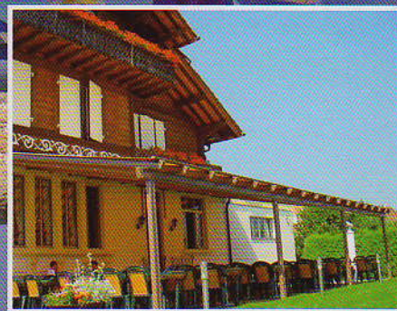
Montage unter Pergola
